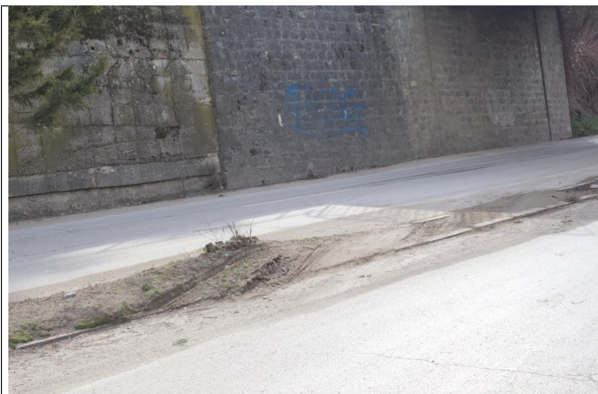
Състояние на разделителен остров на ул. „Опълченска“ с ясно видими следи от гуми на преминавали автомобили от едното към другото платно за движение
