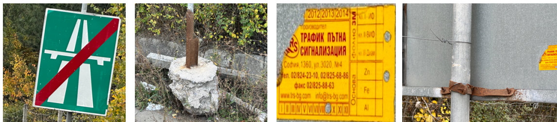
Д6 – дясно км 31+242 Основа на ПЗ Д6. Стикер (чл. 6, ал.4 Н18) Начин на захващане на знака към носещата конструкция
