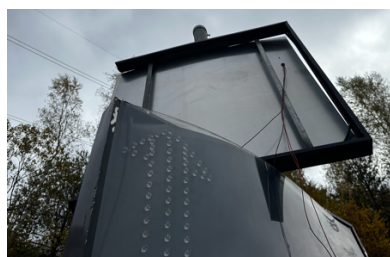
Остатъци от пътните знаци след удар с огледало на тежкотоварен камион и остатъци от огледалото на камиона.
