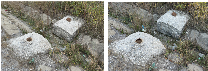
Фундамент на пътен знак, който е бил направен в отводнителното съоръжение
