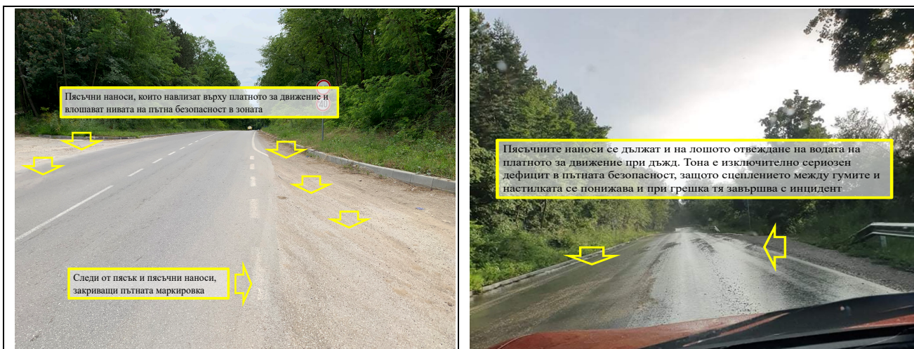
На места пясъчните наноси дори закриват пътната маркировка, което допълнително повлиява негативно върху пътната безопасност Видими следи от пясъчни наноси по платното за движение след дъжд. Тези наноси продължават да стоят на платното дори и когато то е изсъхнало.
