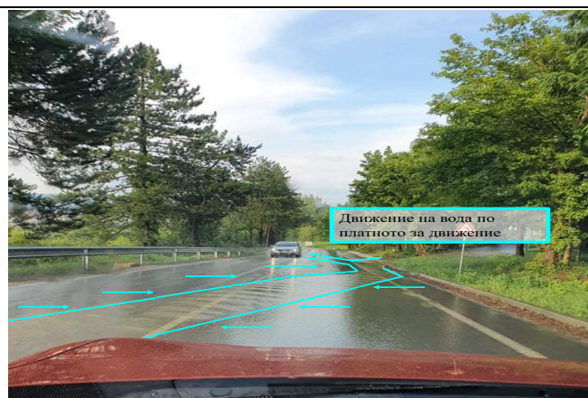
Отводняване на платното за движение след извършения ремонт
