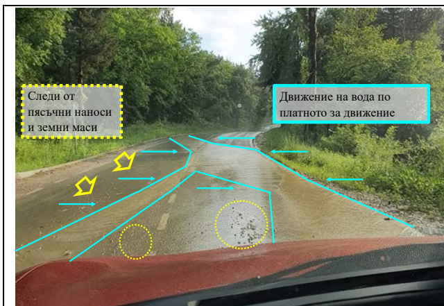
Следи от пясъчни наноси и вода по платното за движение
